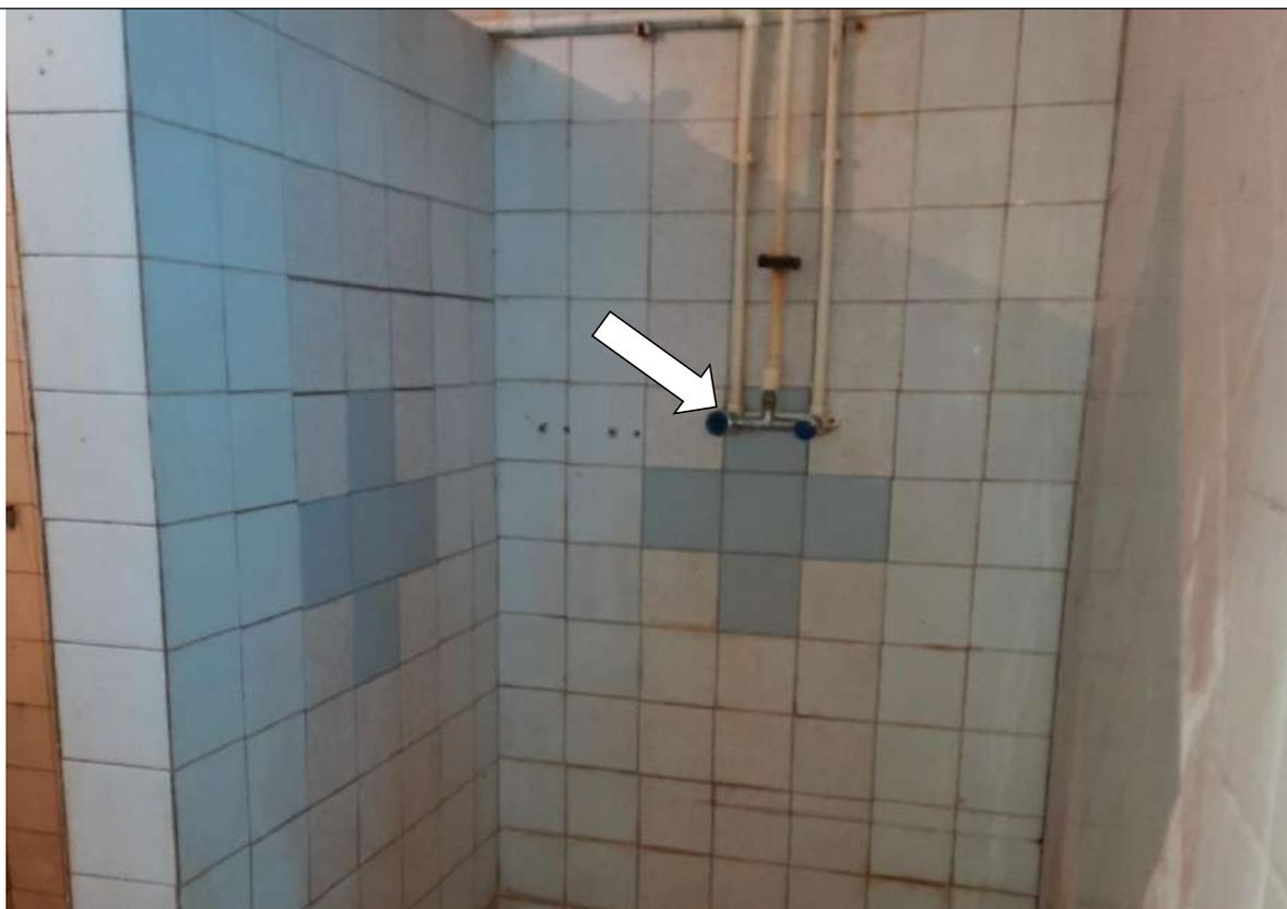
Фото № 12. В душевых установлены краны поворотного типа.
