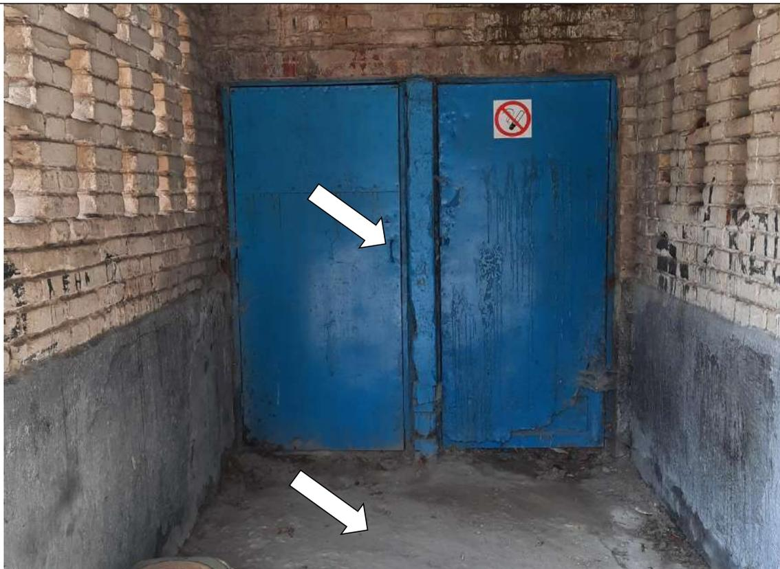
Фото № 7. Дверная ручка контрастно не маркирована. Покрытие поверхности перед эвакуационным выходом имеет неровности.
